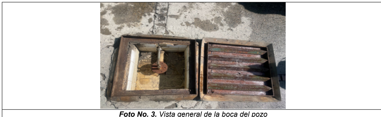
Foto No. 3. Vista general de la boca del pozo
